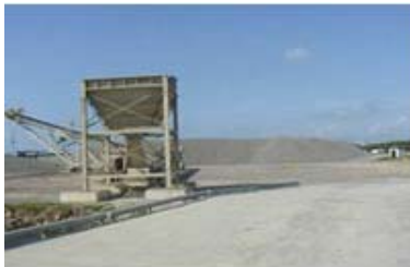
280,000 toneladas de balastro de granito importado de Nueva Escocia, Canadá.
