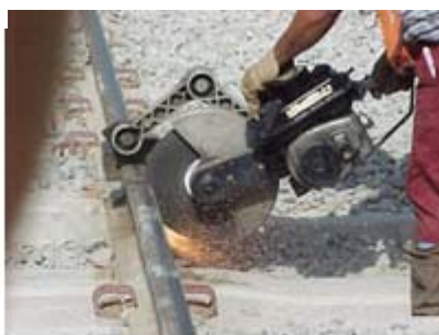
11,000 toneladas de riel de 136 lb. continuamente soldado comprado a Sydney Steel en Canadá
